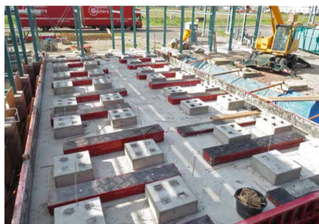
Erster Bauabschnitt: Fundamente für die neuen acht Blending-Tanks.
