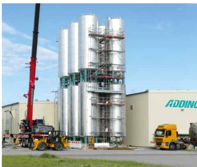
Letzter Bauabschnitt: Installation der Rohrleitungen zum Zentralregister
